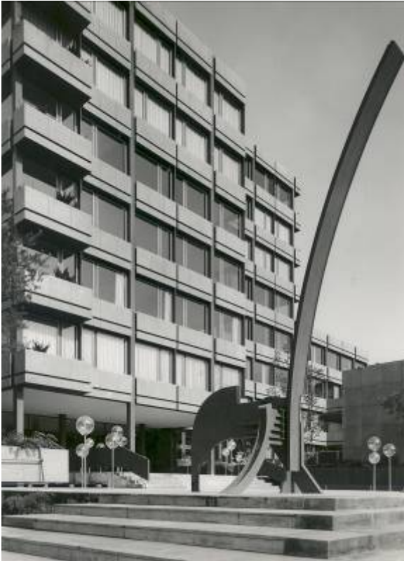
Facciata della Rückversicherung a Zurigo in Castione Nero
